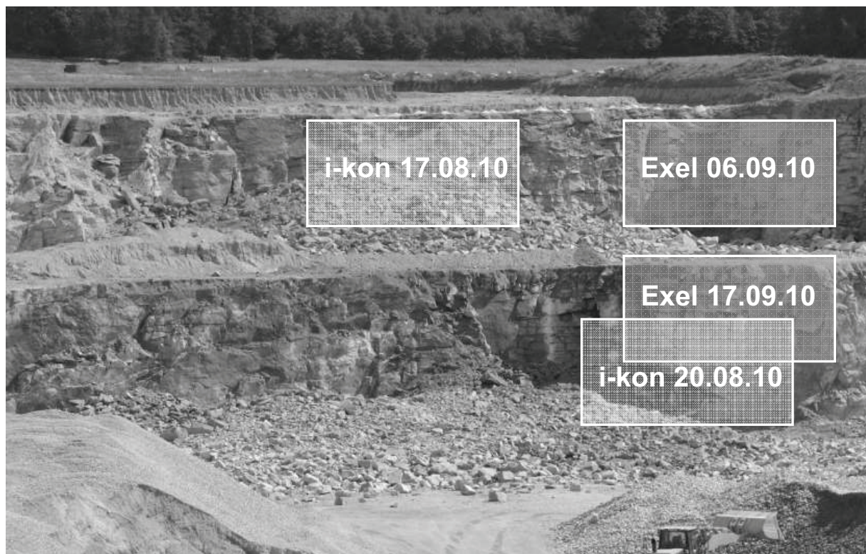
Fot 1. Zdjęcie z naniesioną lokalizacją odstrzałów [1] Fig 1. Picture of the quarry production levels and blasts location
